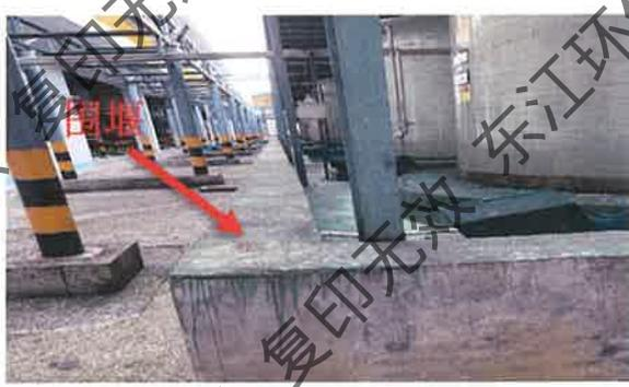
图 4.1-34 危废储罐区围堰及地面防腐防渗
