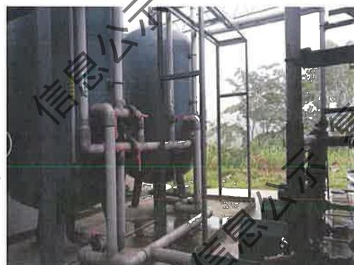
图 4.1-26 生活污水碳滤/砂滤罐
