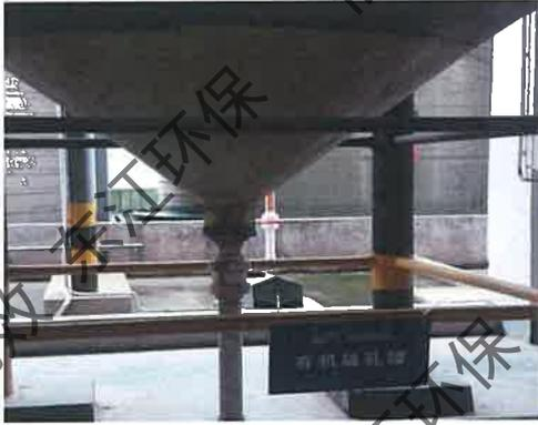
图3.6-17 有机破乳中和反应罐
