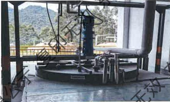
图3.6-19 含氟废液反应釜
