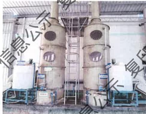
图4.1-4 含铜废液综合利用车间废气处理设施
