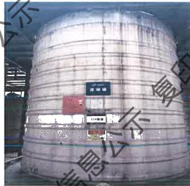
图3.6-11 废酸储罐
