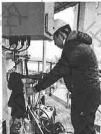
危险废物焚烧炉废气处理后排放口采样
