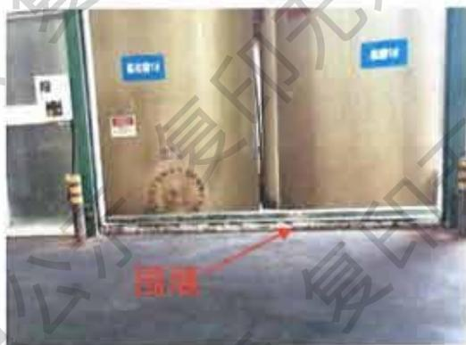
图 4-29 B 仓库地面防腐防渗及围堰
