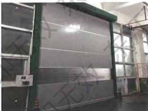
图 4-14 B 仓库废液储存卷帘门
