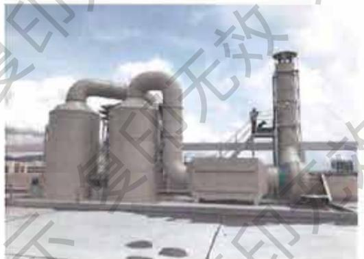
图 4-11 焚烧物料预处理废气处理设施
