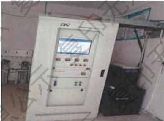
图 4-49 废气在线监测系统
