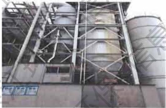
图 4-7 焚烧车间急冷塔及半干式脱酸塔
