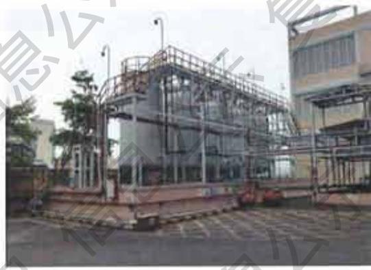
图 4-13 焚烧车间废液封闭储罐
