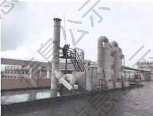
图 4-10 废包装桶回收废气处理设施
