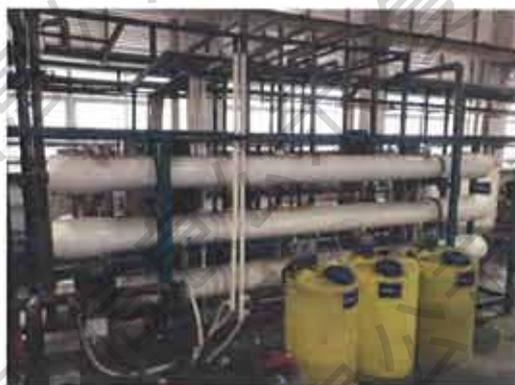
图 4-22 反渗透系统 (RO)
