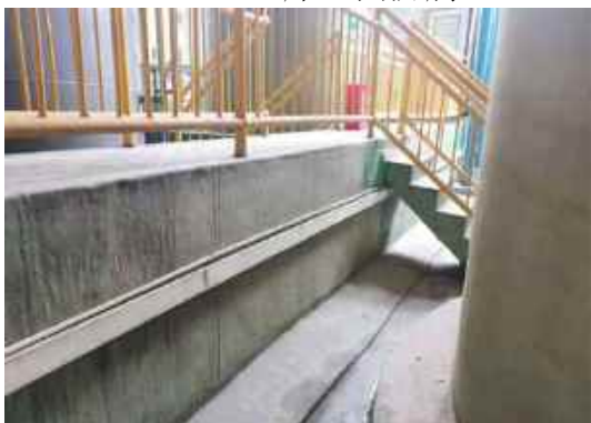
罐区防泄漏围堰
