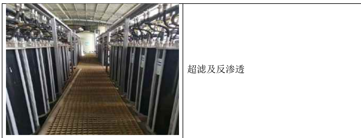
图 4.1-6 项目废水深度处理系统
