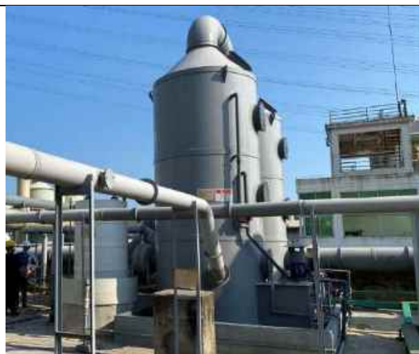
7#厂房两级酸液喷淋塔（序号11）
