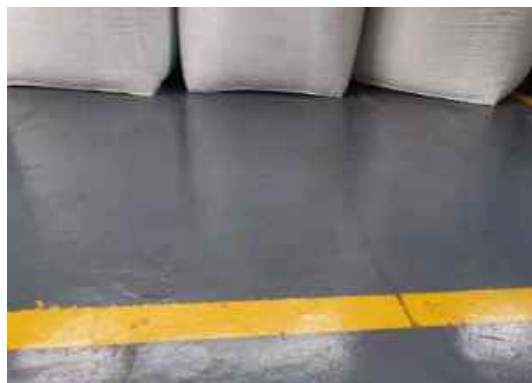
仓库地面防腐
