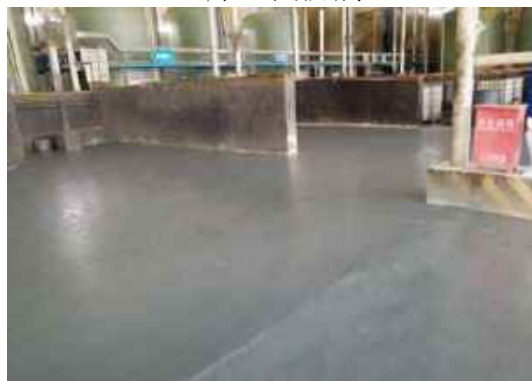
卸水区地面防腐
