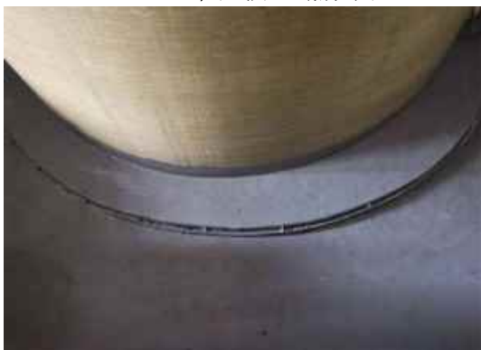
罐区地面防腐
