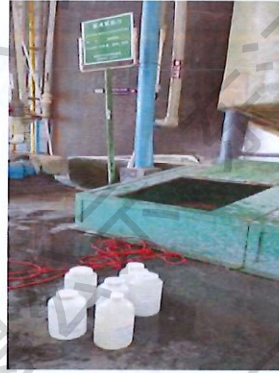
DW002 含重金属废水排放口
