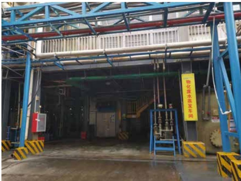
处理“高盐废水+有机废水”的MVR蒸发器与三效蒸发器
