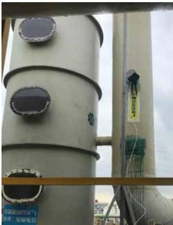
6#厂房压滤机碱性尾气两级酸液喷淋塔（序号2）
