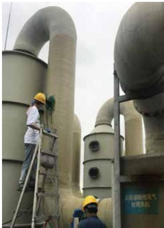
6#厂房反应罐碱性尾气两级酸液喷淋塔（序号4）
