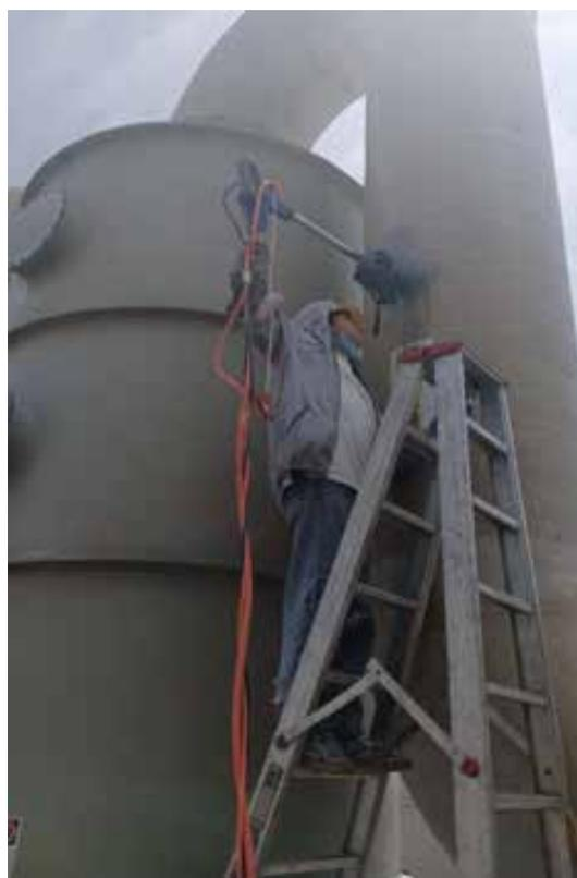
实验室尾气两级碱液喷淋塔（序号5）
