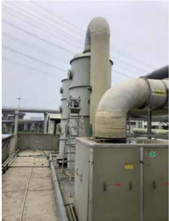
含铜废蚀刻液暂存及预处理车间-四级碱液喷淋塔（序号 8）
