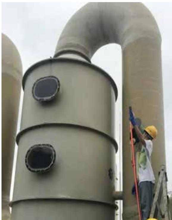
6#厂房反应罐酸性尾气两级碱液喷淋塔（序号3）
