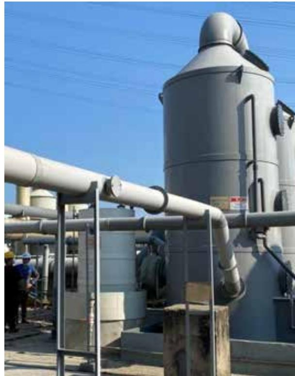
7#厂房两级酸液喷淋塔（序号 11）
