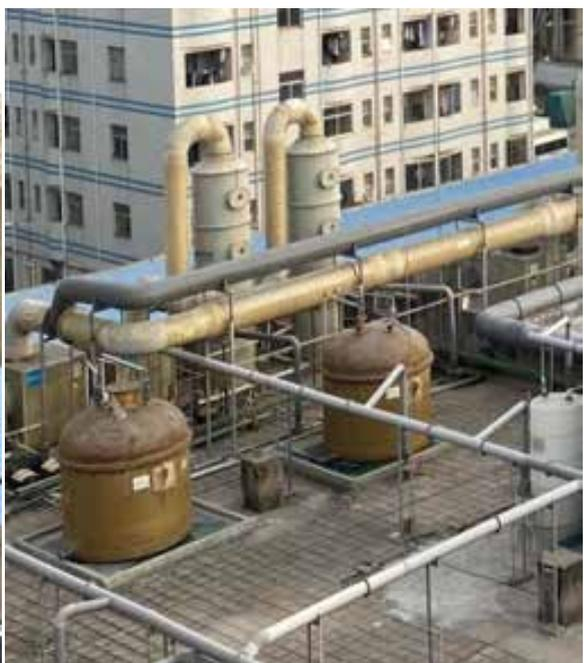
含铜废蚀刻液暂存及预处理车间-两级酸液喷淋塔（序号 9）
