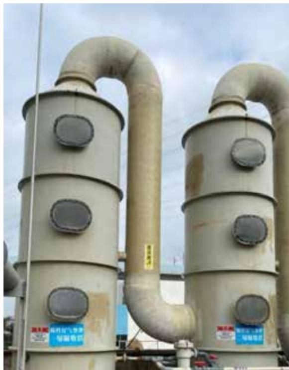
6#厂房压滤机酸性尾气两级碱液喷淋塔（序号1）
