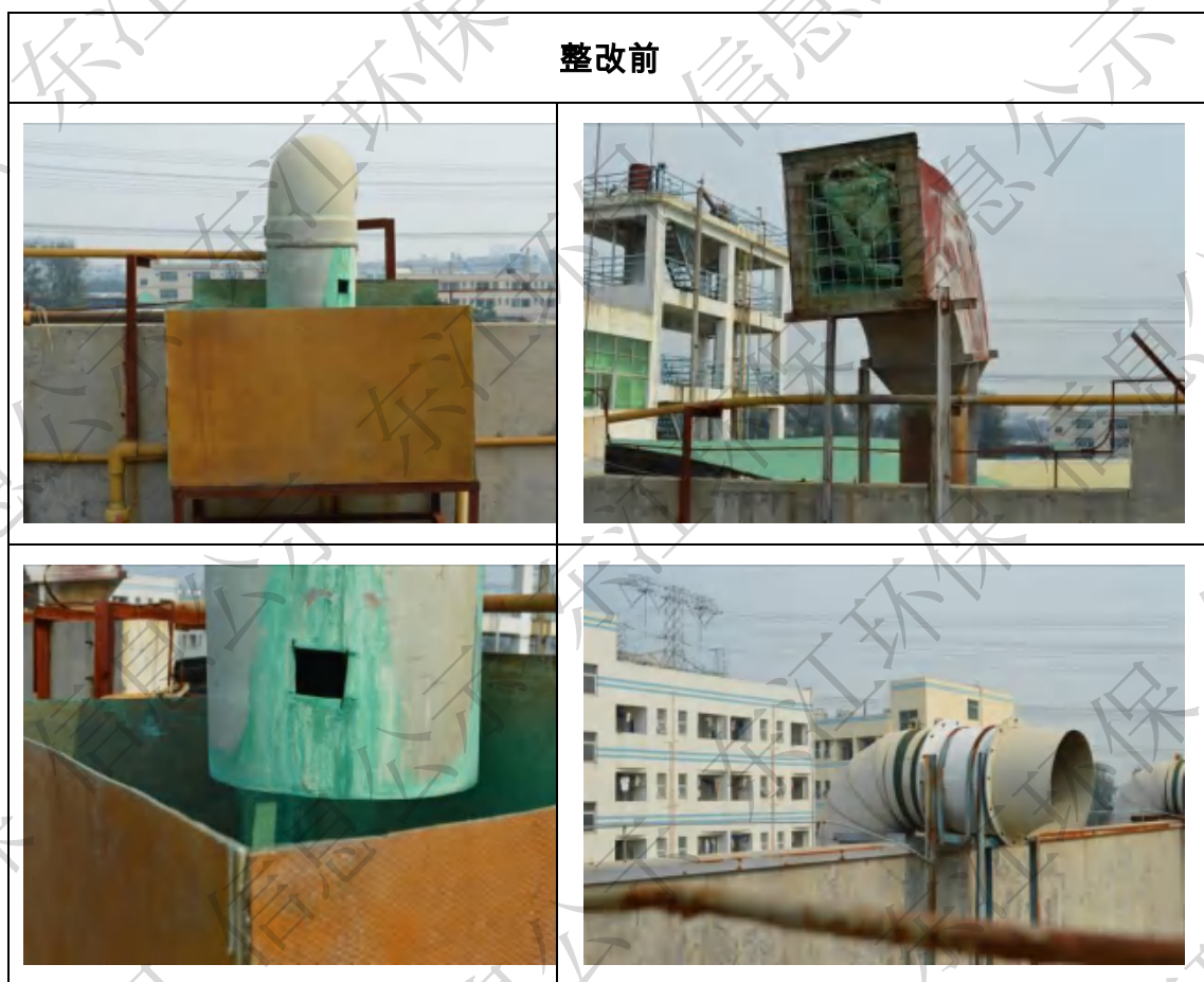
图 3.9-4 华瑞车间废气治理设施及排气筒整改前后对比情况
