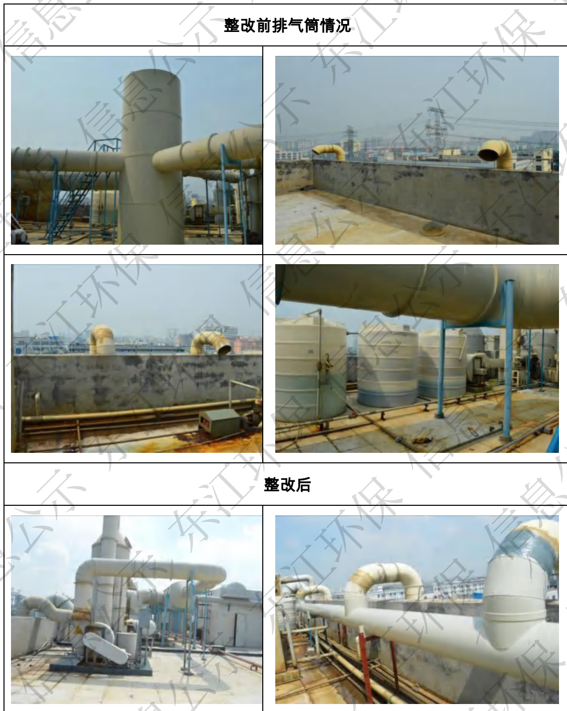
图 3.9-3 6#铜盐车间废气治理设施及排气筒整改前后对比情况
