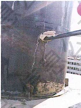
DA005 废气排放口 3 处理后
