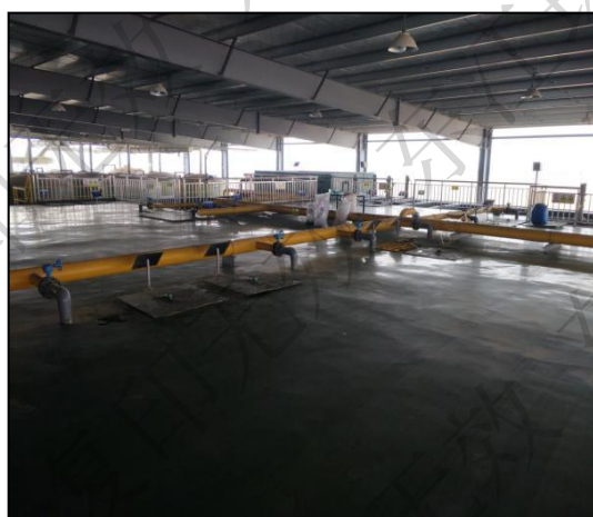
图 4-12 车间地面防腐防渗
