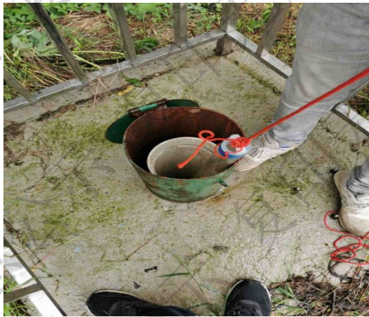
地下水检测井☆6
