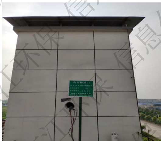
食堂油烟废气出口◎8
