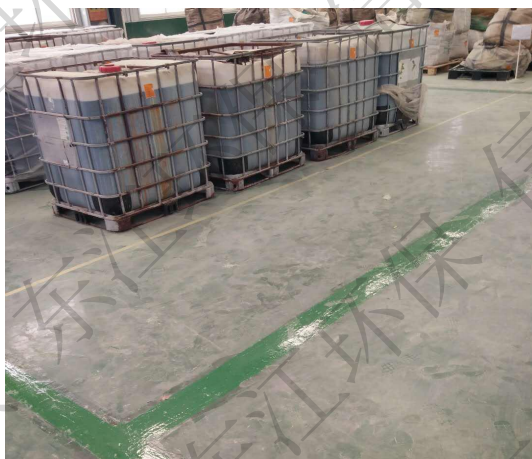
图 4-16 危险废物贮存仓库地面防腐
