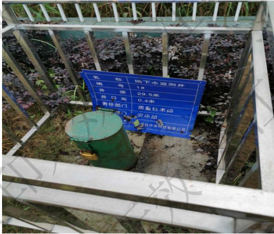
地下水检测井☆1
