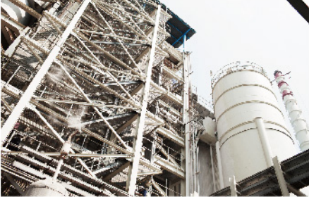
沿海固废处置中心 主要采用热解气化焚烧工艺，安全处 置医药企业产生的危险废物 YUANHAI SOLID WASTE DISPOSAL CENTER Safely disposing medical waste using thermal vaporization and incineration process.
