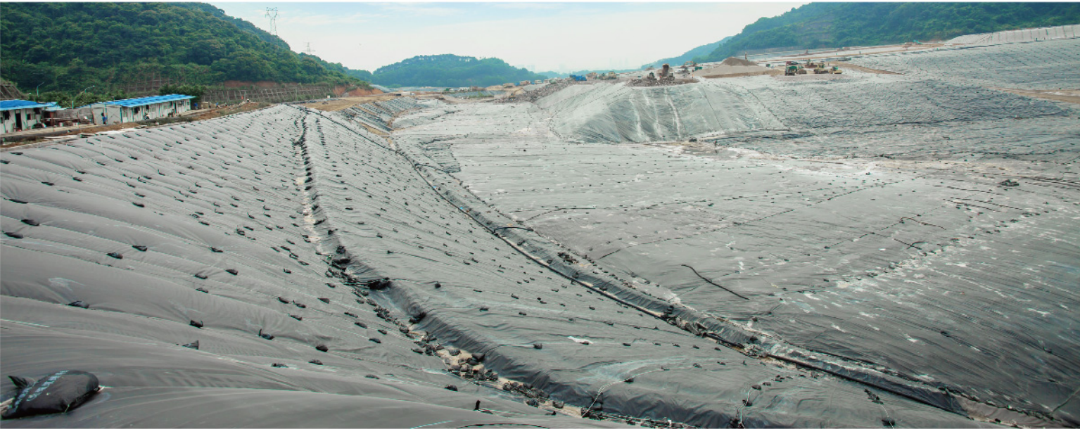
深圳市下坪垃圾填埋场 日处理生活垃圾约4000吨，绿化垃圾约400吨 SHENZHEN XIAPING LANDFILL Daily capacity 4000 ton, about 400 ton green waste
