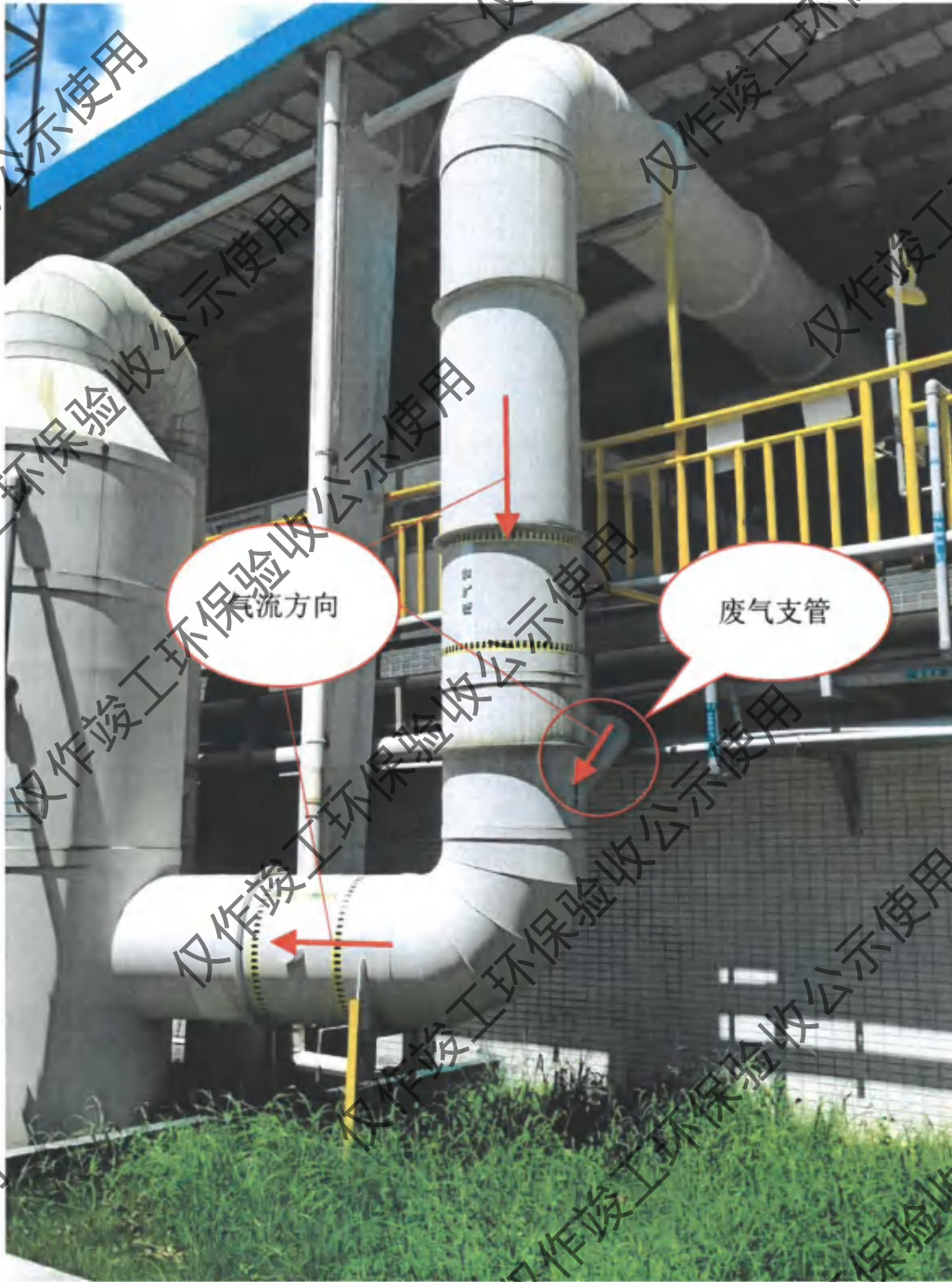
图 7.2-1 污水处理车间废气处理设施进口不具备监测条件详情
