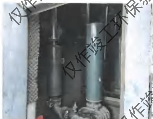
图 4.1.3-2 主要噪声源安装吸声材料
