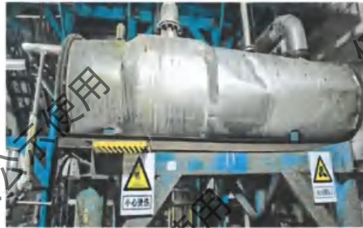
图 4.1.1-8 MVR 蒸发器
