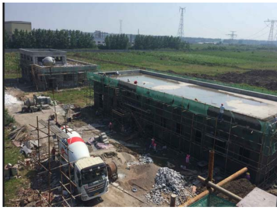
鼓风机房施工工程
