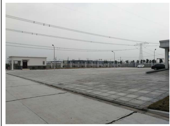
道路广场区广场监测过程
