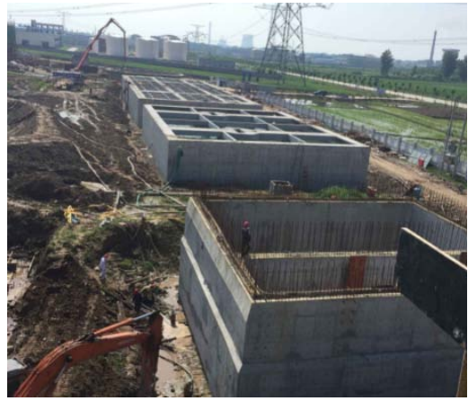
粗栅格施工工程
