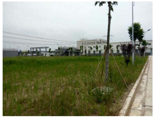
预留扩建区监测过程
