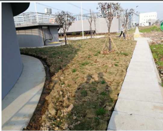
构筑物区监测过程
