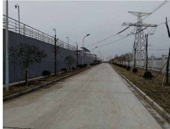
道路广场区道路监测过程
