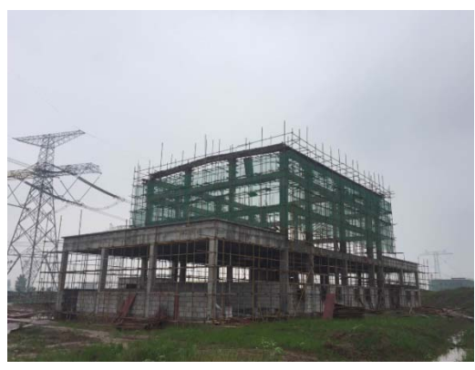
脱水机房工程
