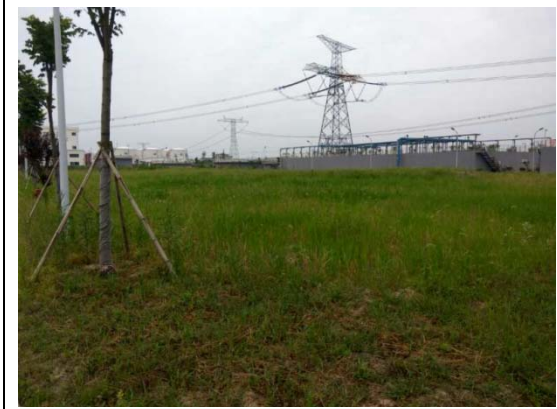
预留扩建区监测过程
