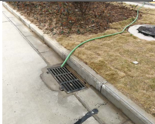
构筑物区雨水排水监测过程
